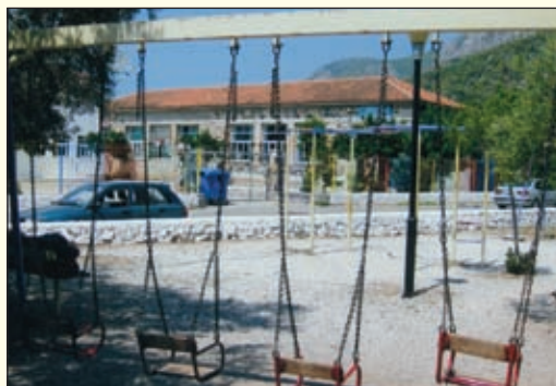
Εικ. 5: Όχι άνω των 2 καθισμάτων ανα κατασκευή. Πολύ βαριά καθίσματα
