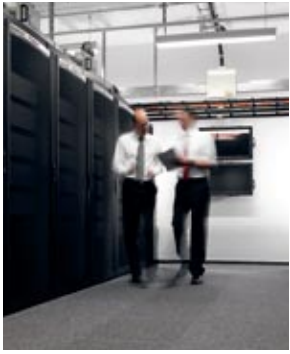
Server room at Neue Börse
