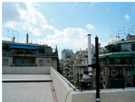
Σταθμός Μέτρησης 24ωρης παρακολούθησης ηλεκτρομαγνητικής ακτινοβολίας
