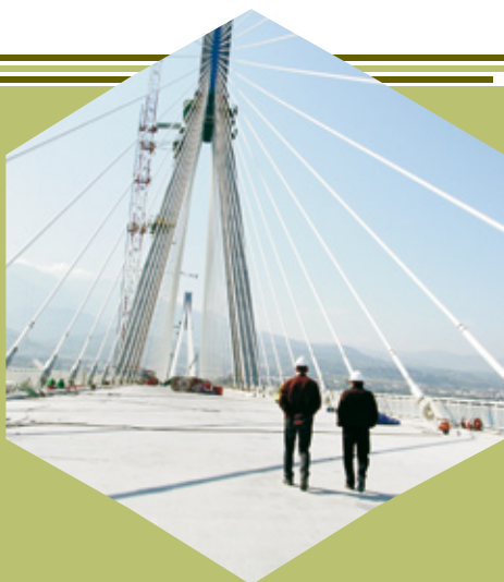
Άποψη της γέφυρας Ρίου - Αντιρρίου
