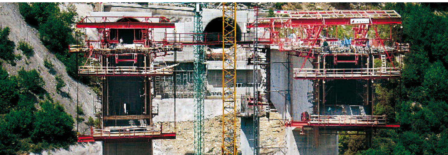
Εγνατία Οδός - Άποψη Γέφυρας Μετσόβου
