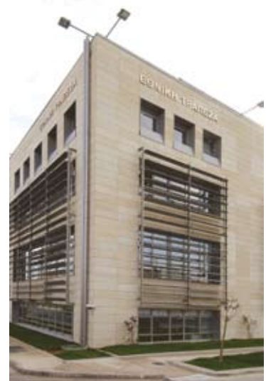
Κτήριο Μονάδων Διοίκησης στο Γέρακα
