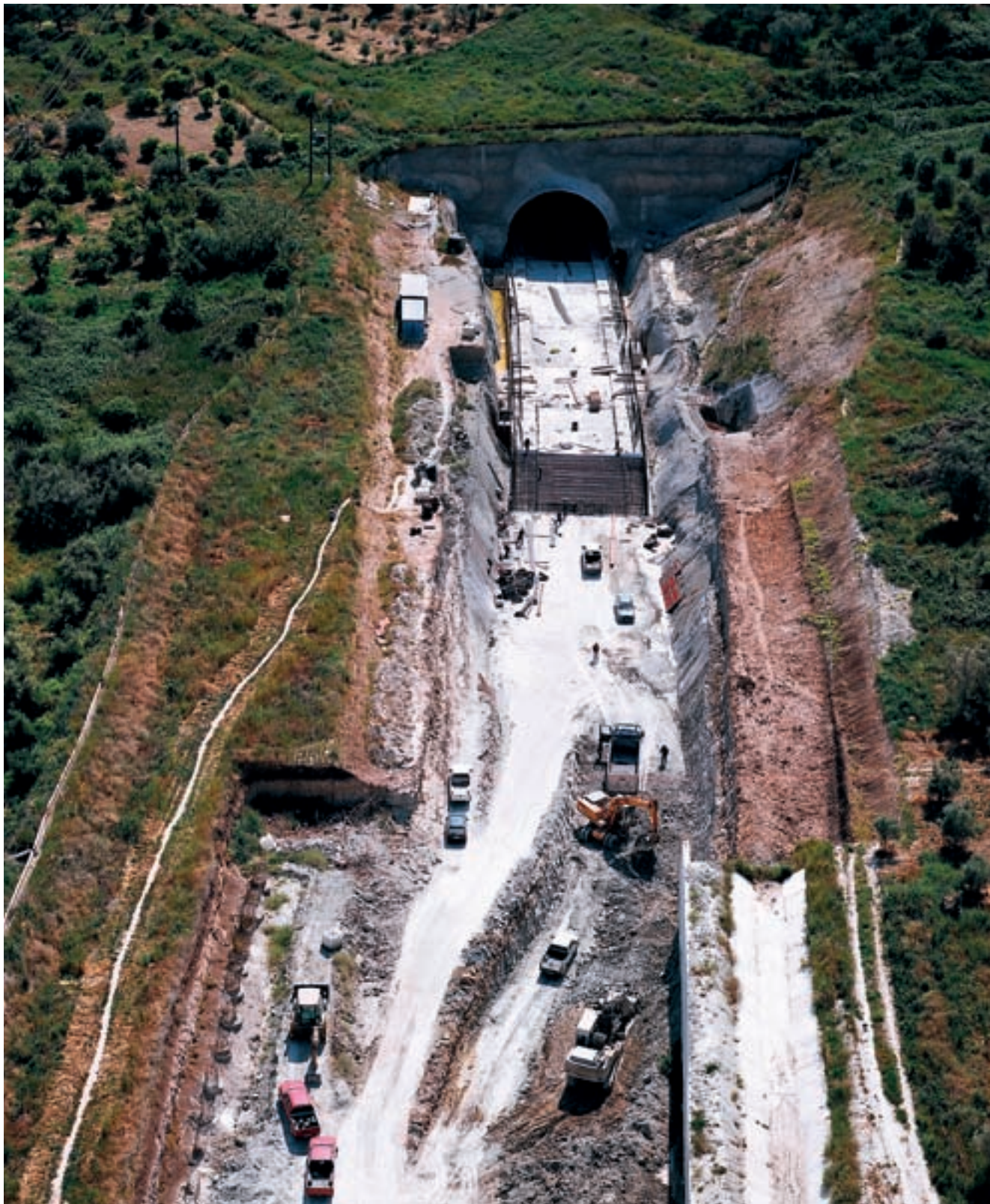
Κατασκευή Σιδηροδρομικής Γραμμής: Τμήμα Ροδοδάφνη-Κιάτο με σήραγγα Μελισσίου
