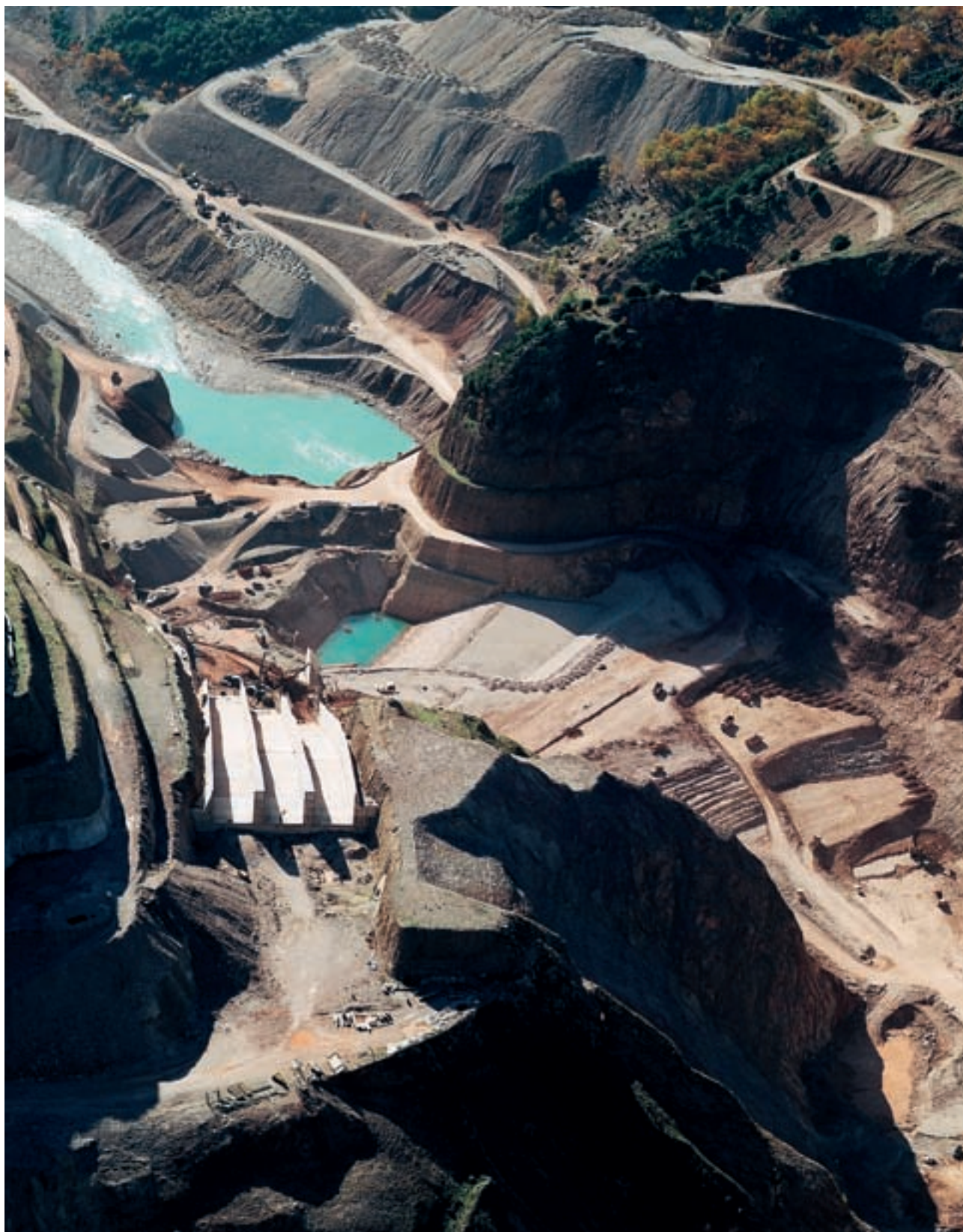
Αποπεράτωση Φράγματος Συκιάς
