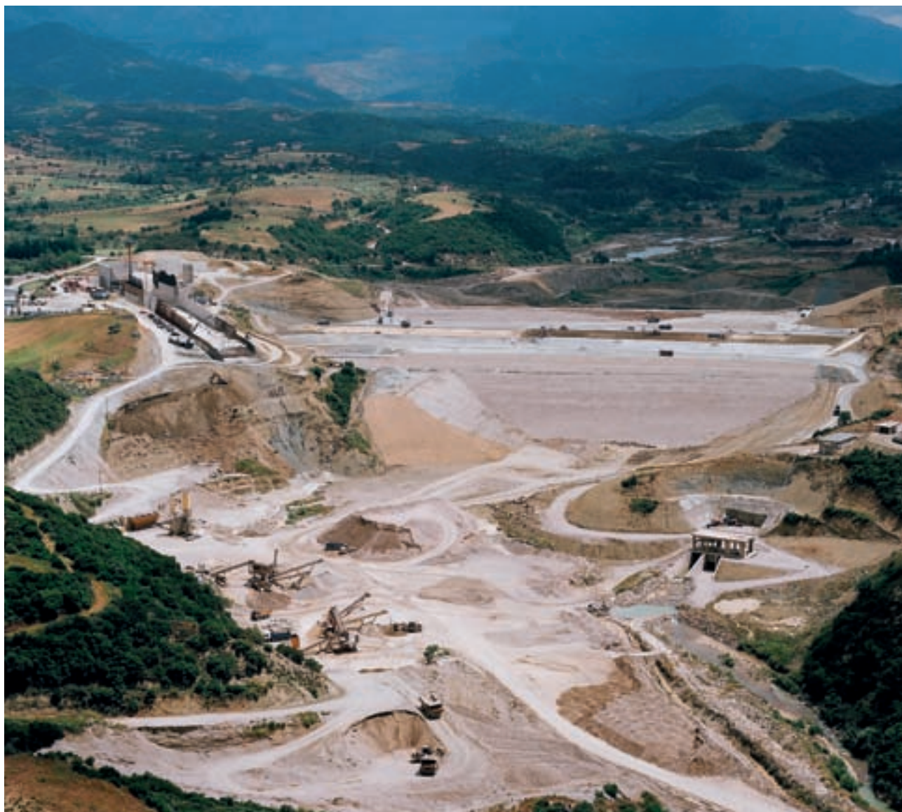
Κατασκευή Φράγματος Πείρου Παραπείρου
