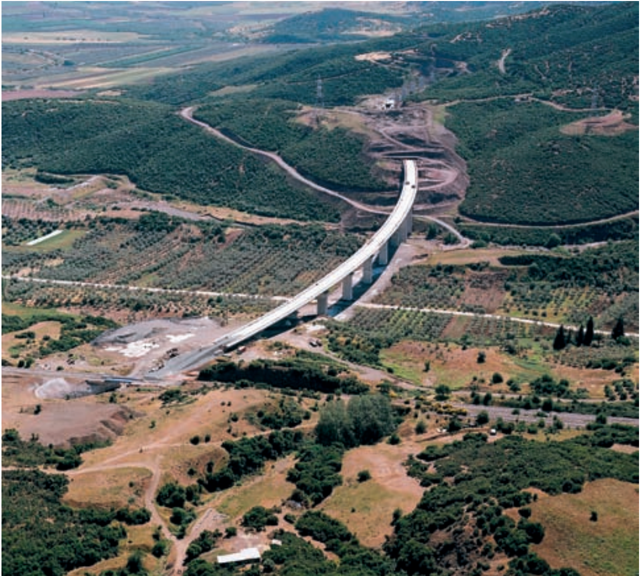
Κατασκευή Σιδηροδρομικής Γραμμής: Τμήμα Λιανοκλάδι-Δομοκός
