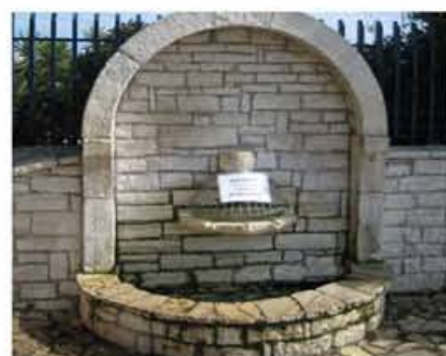
Βρύση με ειδικό φωτοκύτταρο για ελεγχόμενη χρήση νερού, Αίγιο (εργοστάσιο Αύρα).
