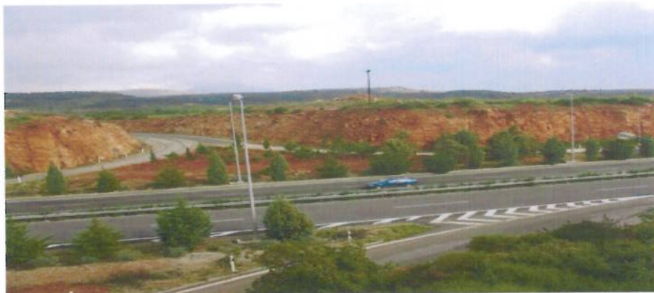
Άποψη Αυτοκινητόδρομου Κορίνθου - Τριπόλεως
