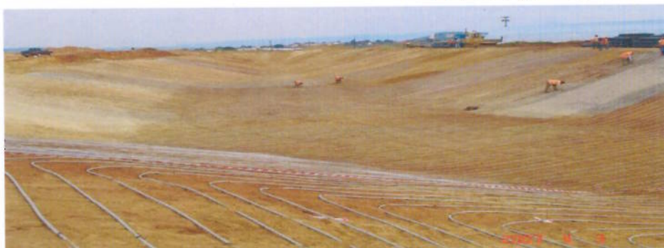
Άποψη εφαρμογής γεωθερμίας
