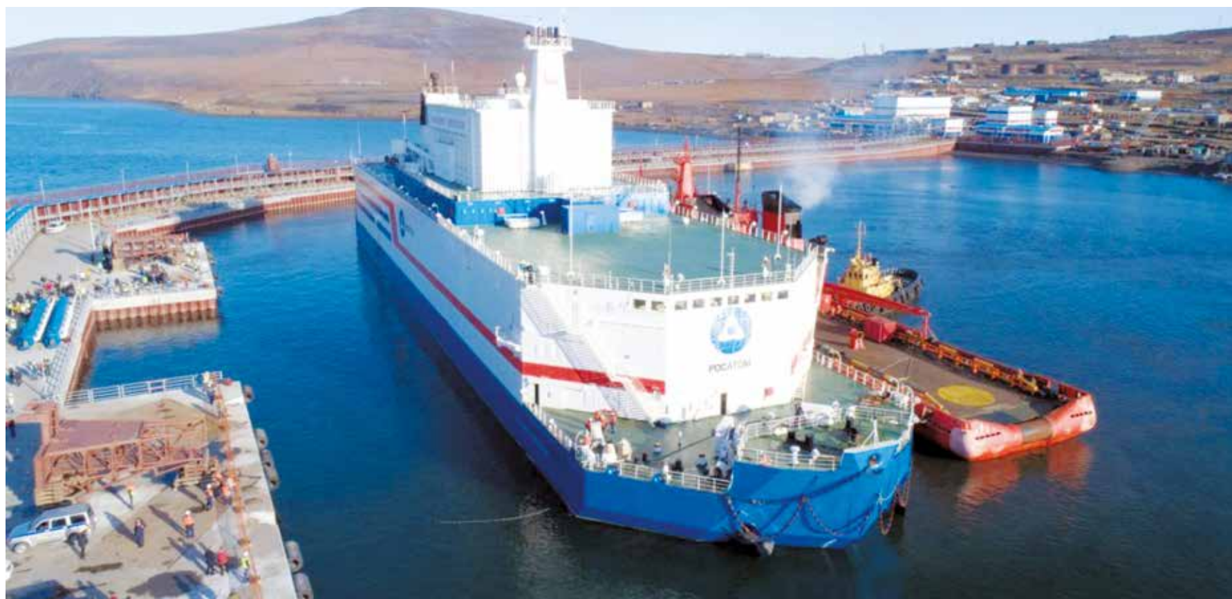
Εικόνα 2: Ο εν ενεργεία πλωτός πυρηνικός σταθμός παραγωγής ενέργειας Akademik Lomonosov στη Ρωσία. 8 © Copyright Rosenergoatom
